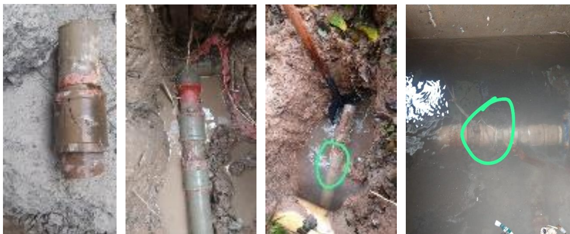
Figura 24: Identificação e eliminação de vazamentos ocultos
